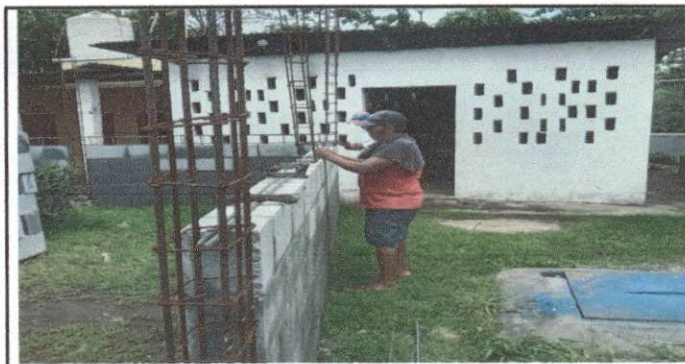
Foto 6: Elaboración de Estructuras
