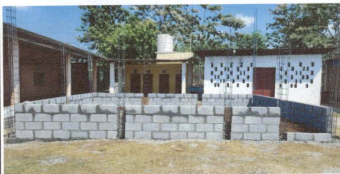
Foto 1: Se continuará la construcción paredes del aula, que mide 6 metros por 8 metros.
