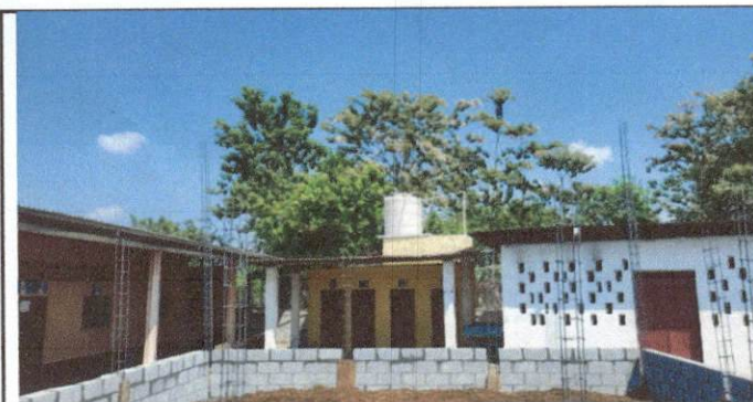
Foto 3: Se colocara el techo de lamina de 81 metros cuadrados, y sus sistema electrico.
