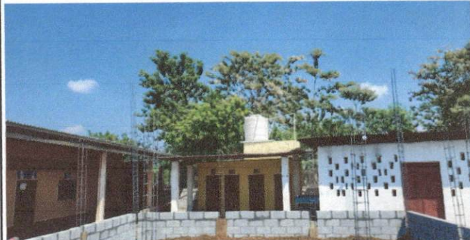
Foto 2: Se incluire el la colocacion de 45 metros cuadrados de piso ceramico.
